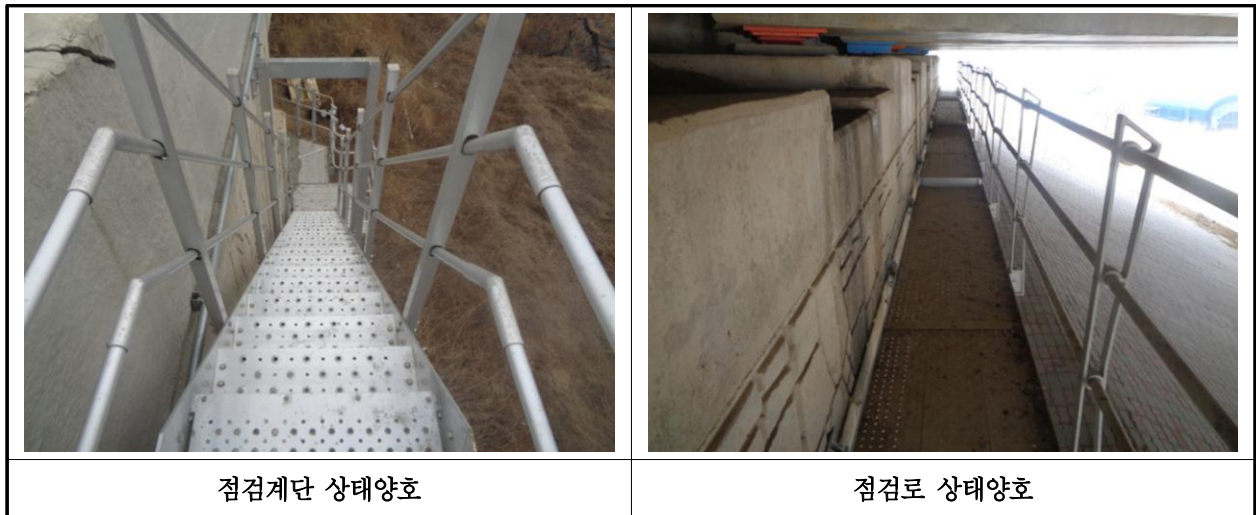
【사진 11.3.26】 교량 점검시설 손상현황
