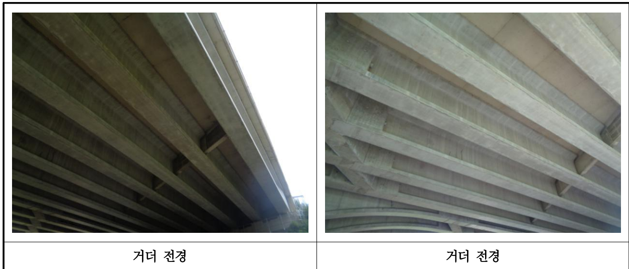
【사진 11.3.4】 거더 전경
