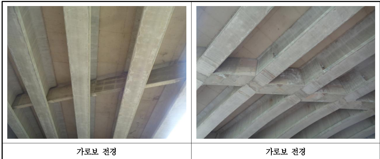
【사진 11.3.6】 가로보 전경
