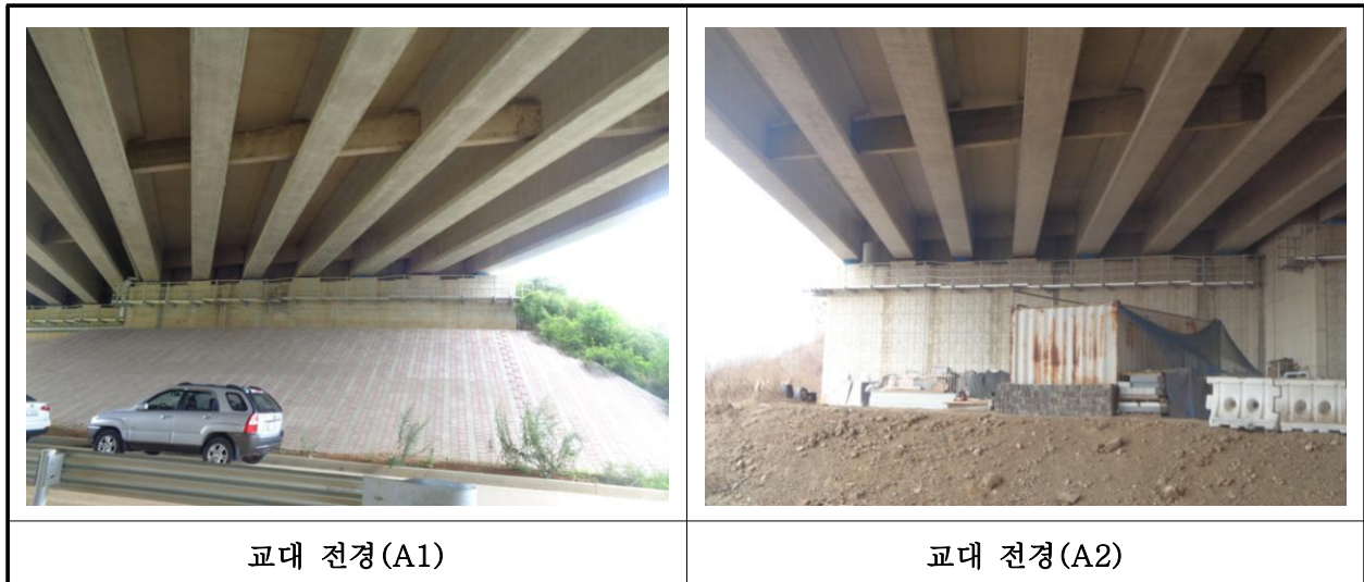
【사진 11.3.8】 교대 전경
