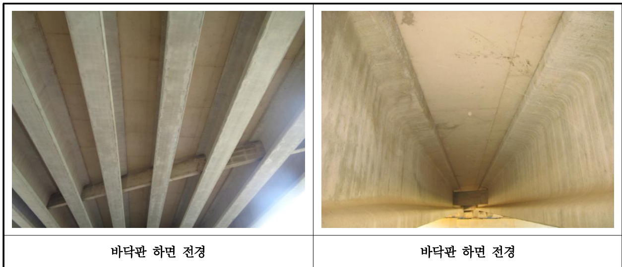
【사진 11.3.2】 바닥판하면 전경
