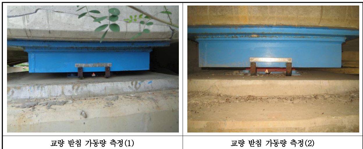
【사진 11.3.15】교량받침 이동량 측정
