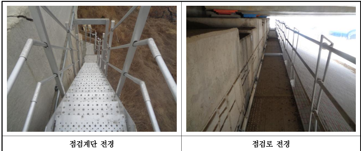
【사진 11.3.25】 교량 점검시설 전경
