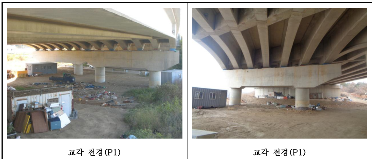
【사진 11.3.10】 교각 전경
