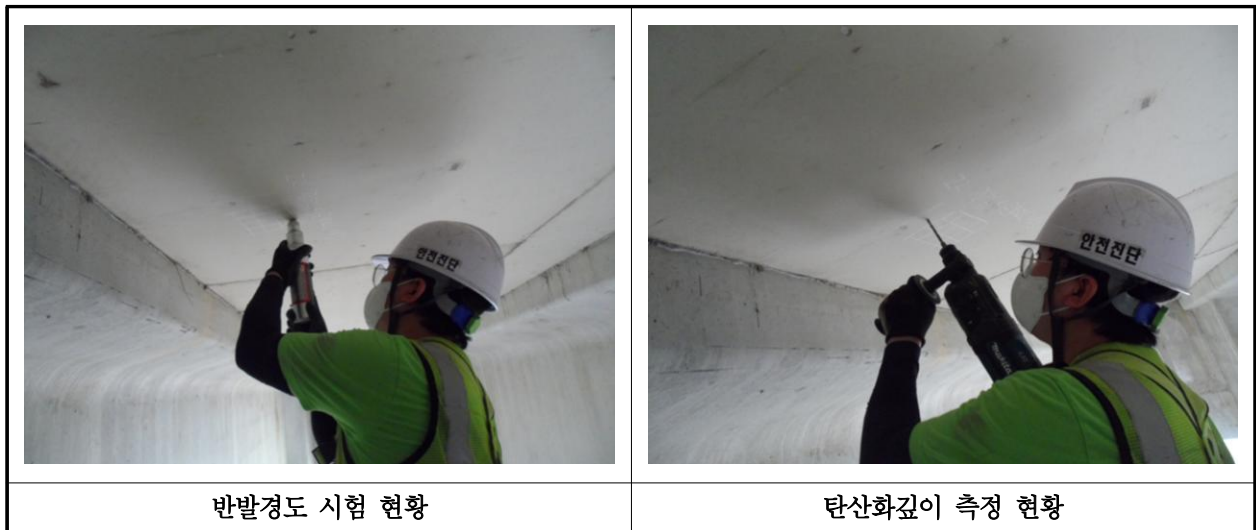
【사진 11.4.1】 콘크리트 내구성조사 현황
