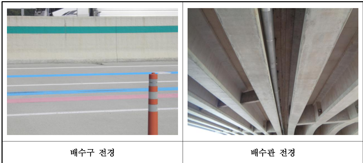
【사진 11.3.21】 배수시설 전경
