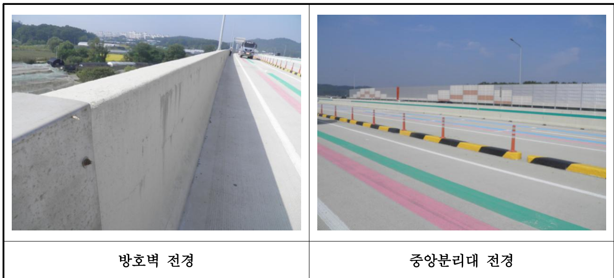
【사진 11.3.23】 방호벽 및 중앙분리대 전경
