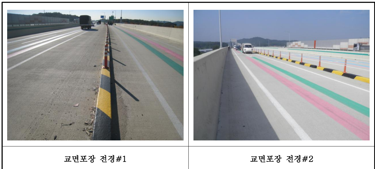
【사진 11.3.19】 교면포장 전경
