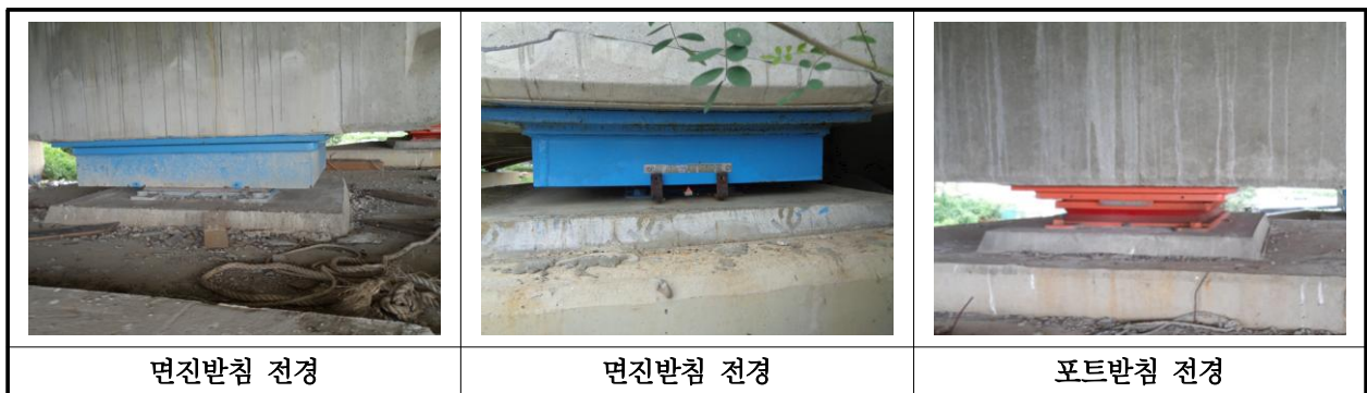
【사진 11.3.12】 교량받침 전경
